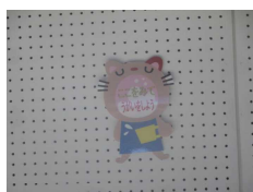
←流し場の天井に貼られた掲示物
