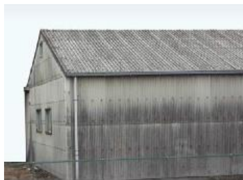
石綿含有スレート波板（屋根・外壁）
