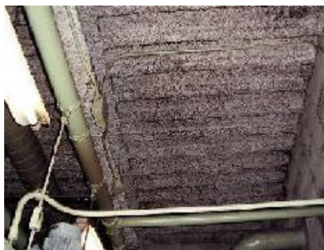
石綿含有吹付けロックウール
