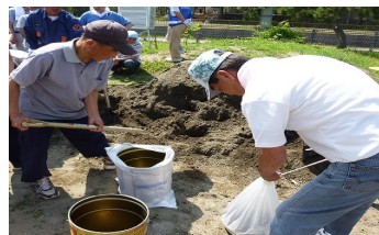
【オイル缶を使った土のう作り】（北文間地区）
