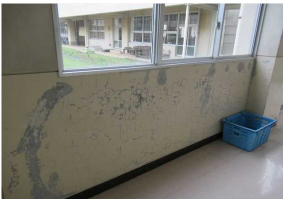
廊下壁の塗装剥がれ（長山中学校 校舎棟）
