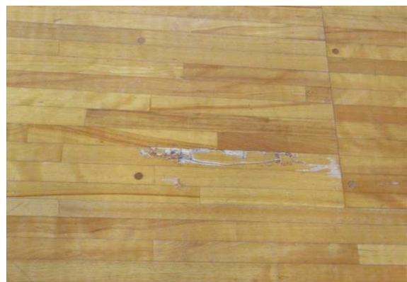
床材の劣化（馴馬台小学校 屋内運動場）
