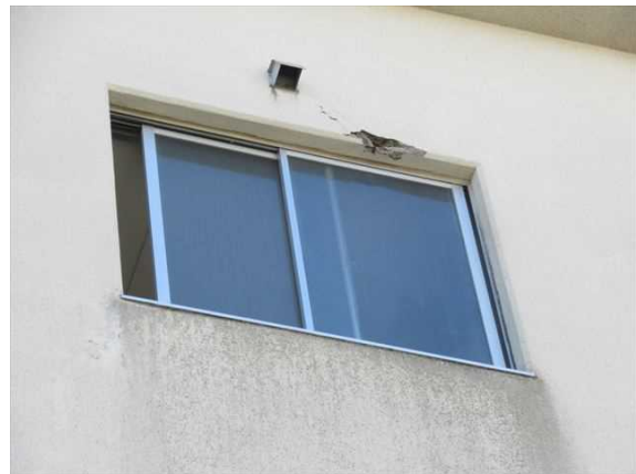
外壁の劣化（龍ヶ崎西小学校 校舎棟）
