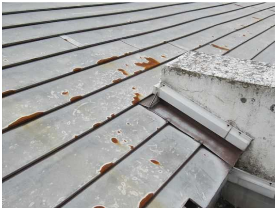
金属屋根の劣化（城南中学校 校舎棟）
