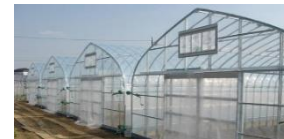
パイプハウス
