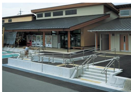
高低差を解消するスロープの設置
