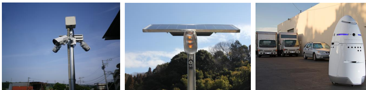
防犯カメラ（モニターは事務室） 屋外照明（防犯灯） 警備ロボット
