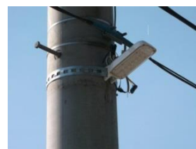
(LED照明の防犯灯)
