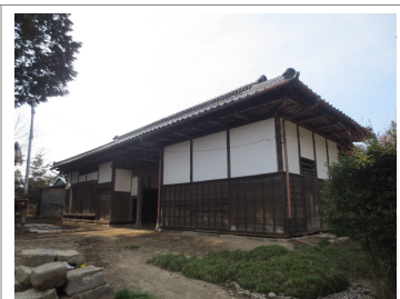
▲矢口家長屋門修復工事
