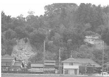
▲崩壊現場箇所の現況
