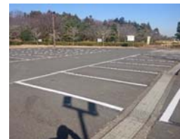
▲駐車場区画線改修
