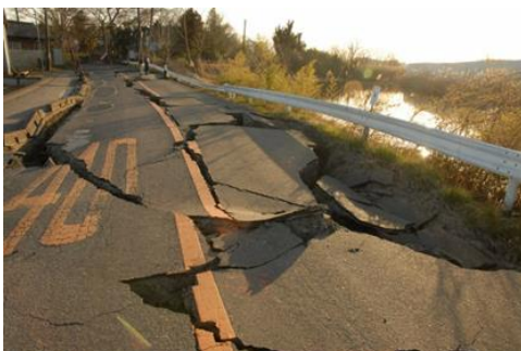
(写真) 東日本大震災被害状況
