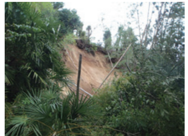
▶平成25年の台風26号によるがけ崩れ被害の様子
