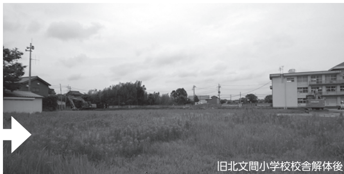
旧北文間小学校校舎解体前
