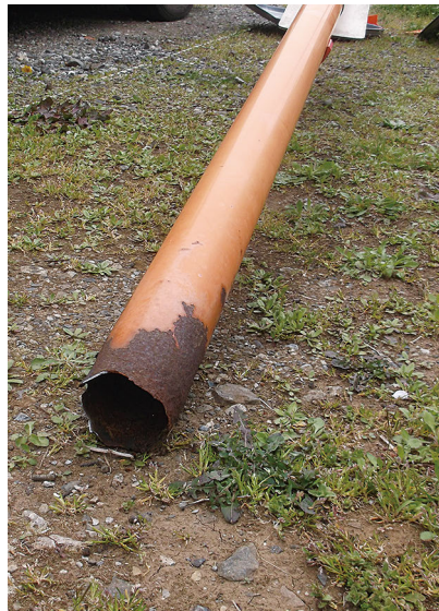
▲カーブミラー／平成 29 年 4 月倒壊(私有地内)
