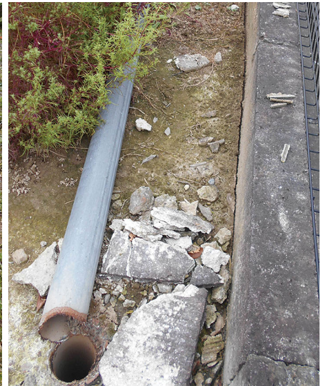
▲防犯灯／令和 2 年 11 月倒壊（私有地内）
