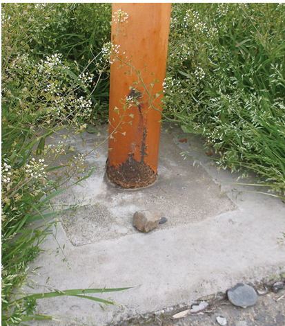
▲腐食したカーブミラー
