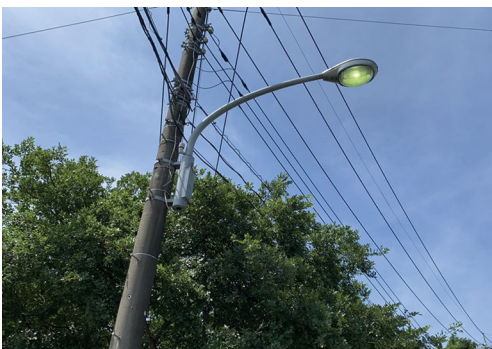
◀道路照明の例
