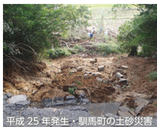
平成 25 年発生・駒馬町の土砂災害
