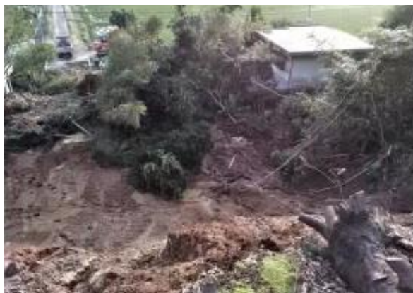
図表4 2013年台風第26号による土砂災害（馴馬町）
