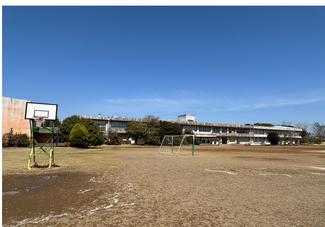
建物外観（南側）
