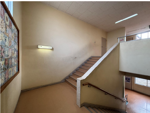
階段 (普通教室側)
