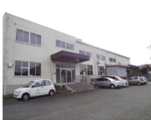
学校給食センター第一調理場
