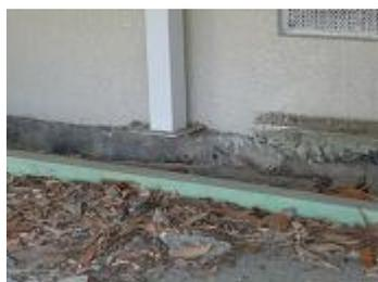
・震災等による地盤沈下の進行による影響で、地下給配水管の脱落や埋設された柵の凹凸、これらに伴う漏水が顕在化しています。また、アスファルト舗装面の凹凸も著しい状態です。
